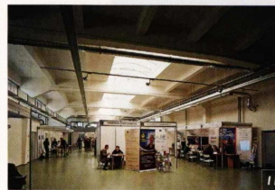
10. Główna przestrzeń komunikacyjna hali garażowej z wyeksponowaną zabytkową konstrukcją budynku 11. Przestrzeń wystawiennicza w przebudowanej hali garażowej 12, 13. Fragment wnętrza przebudowanej hali garażowej
